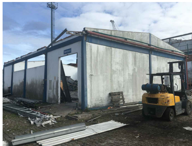
03 FOTO LATERAL DA FACHADA ESC.: Sem Escala
